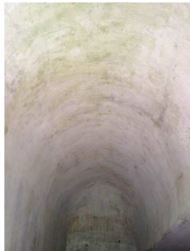
Deckenansicht nach erfolgter Reinigung durch den Malerbetrieb Finger (Michelstadt/Vielbrunn)
