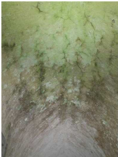
Deckenansicht vor der Reinigung des Jugendstil-Wasserwerks Vielbrunn
